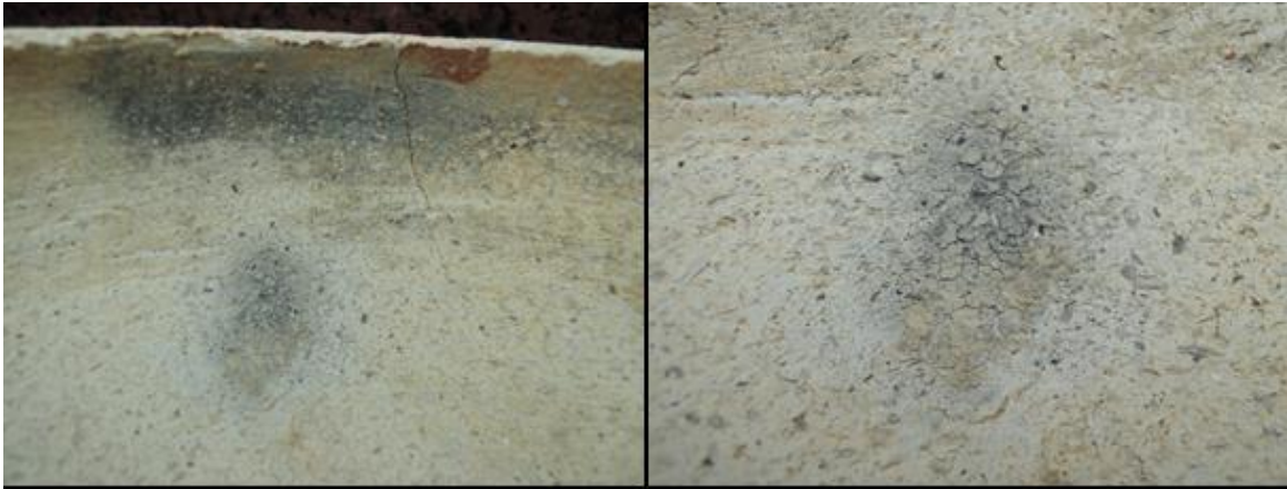
Figura 67 Manchas de queima no interior da tampa
