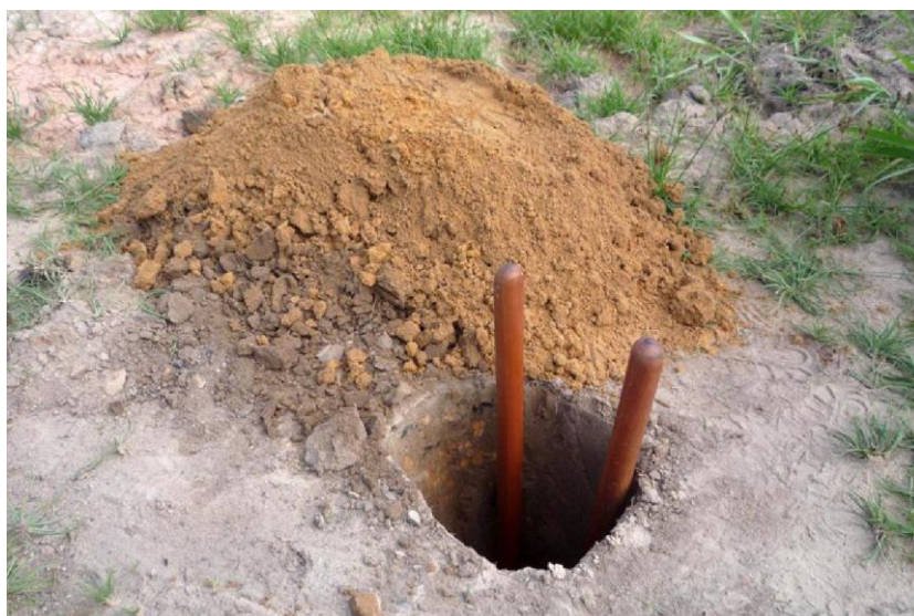
Figura 18 Abertura de poço teste na área 42 ( DOCUMENTO, 2009b, pg.70)
